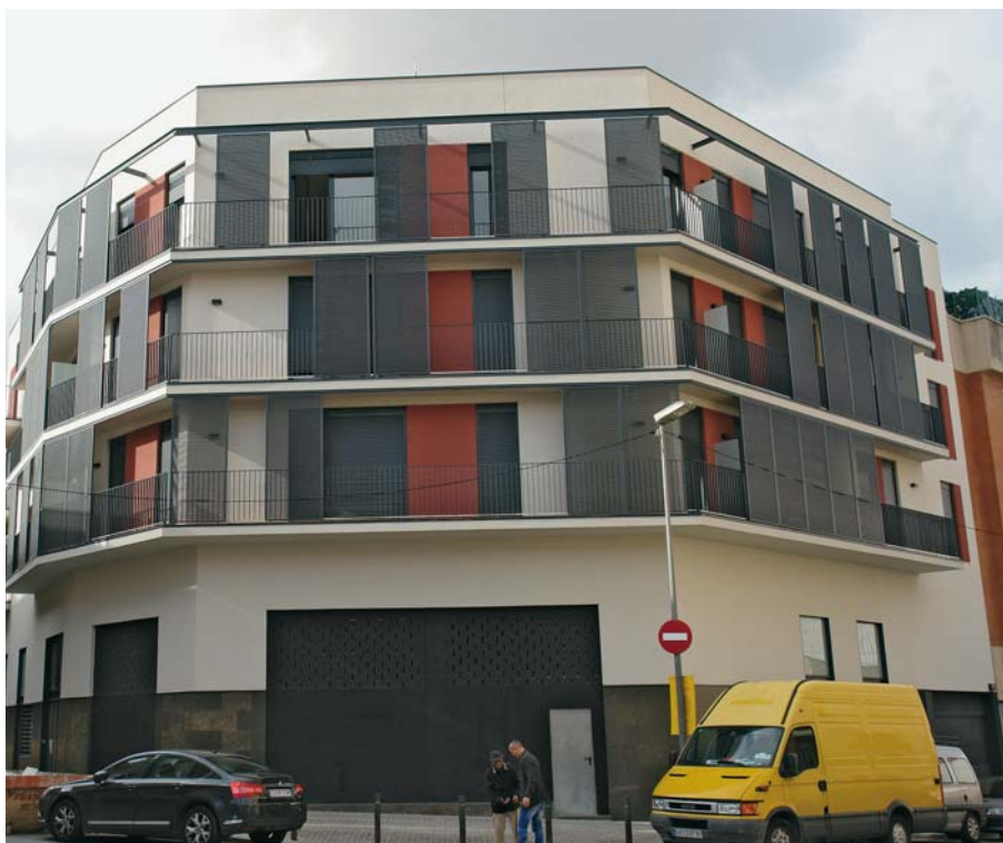
Imagen de la obra acabada con los elementos de protección solar.
